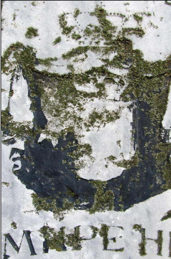
Колоније лишајева на грбу и словима МЕХАНИЧКА ОШТЕЋЕЊА НА СПОМЕНИКУ
