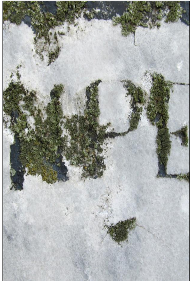
Колоније лишајева на грбу и словима МЕХАНИЧКА ОШТЕЋЕЊА НА СПОМЕНИКУ
